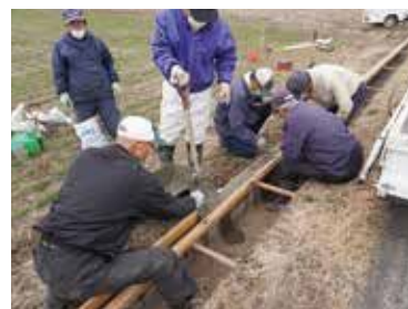
水路側壁の高上げ
