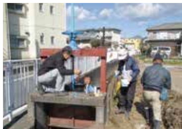
水門の塗装・注油
