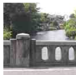
広瀬川と石川橋(本庁管内地区)
