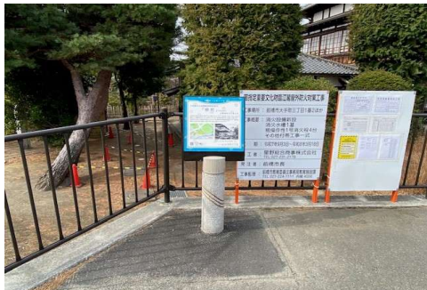
設置事例：柳町
