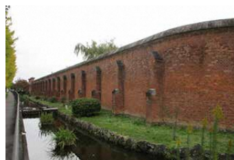
前橋刑務所レンガ塀及び表門 （前橋市景観資産）
