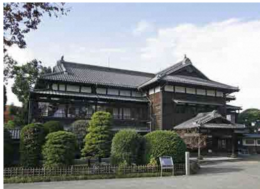
臨江閣（景観資産登録番号第14号） 近代和風の木造建築で、楢取素彦県令や市民有志により迎賓館として建てられた。
