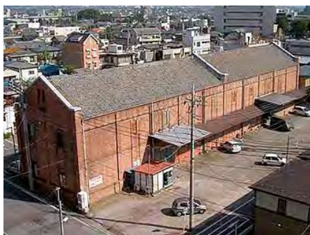
旧安田銀行担保倉庫
