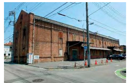
旧安田銀行担保倉庫
