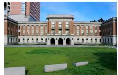
群馬県庁本庁舎（昭和庁舎）
