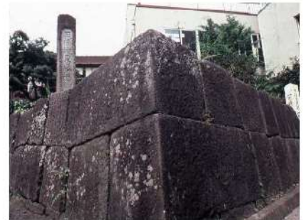
前橋城車橋門跡
