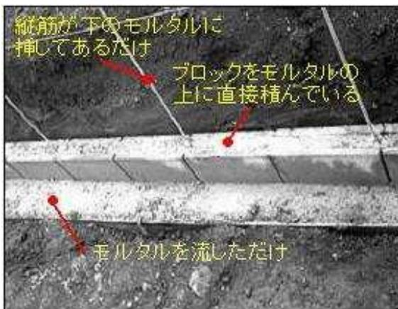
写真4 埋込み基礎の施工例
