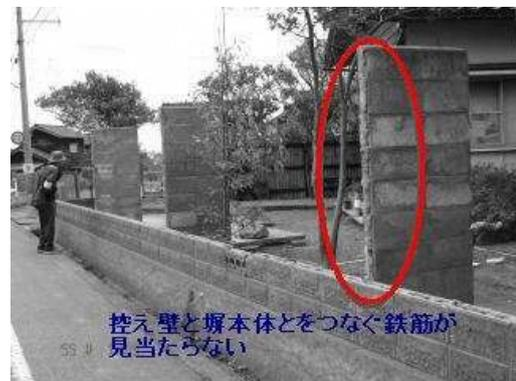
写真9 地震で塀本体が倒壊した施工不良の被害例
