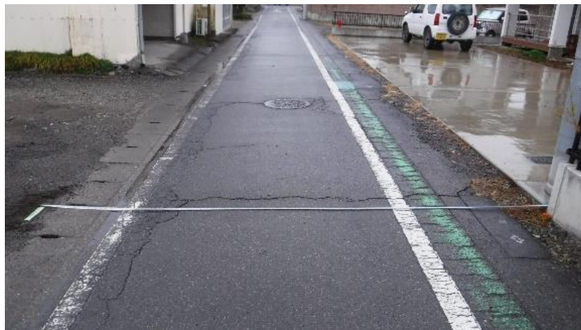
『全景（道路全幅が写っているもの）』
