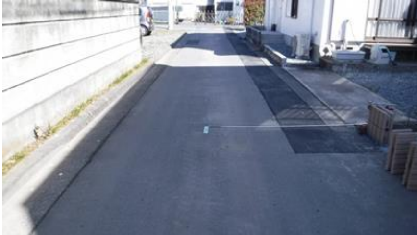
『全景（道路全幅が写っているもの）』
