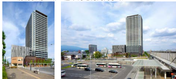
名称：Brillia Tower 前橋（令和6年3月竣工） 用途：分譲共同住宅203戸、子育て支援施設、店舗
