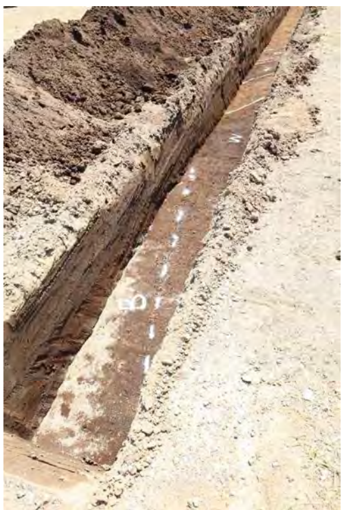
1 トレンチ As-B 堆積部分
