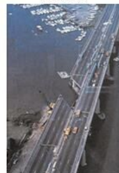
マイアナス橋の落橋 (1983年)
