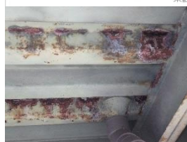
デッキプレートの腐食、漏水
