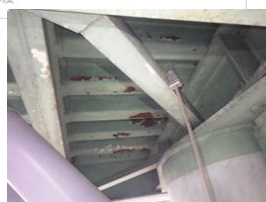
デッキプレートの腐食、漏水
