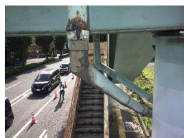
配水管の亀裂や腐食
