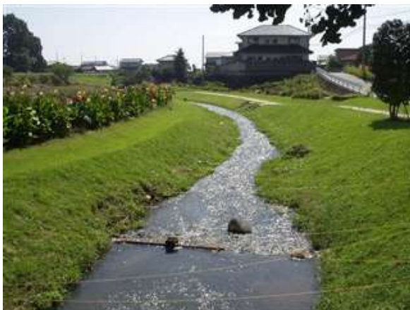
桃ノ木川取水口付近
