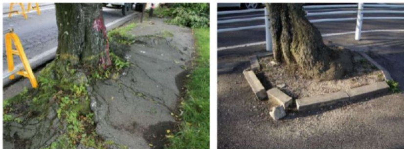
写真 4-11 根上り状況（出典「街路樹再生の手引き」）
