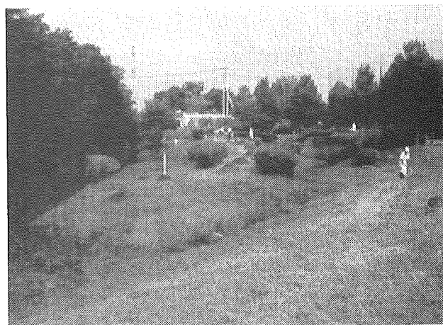
下流端から下流を臨む：完成
