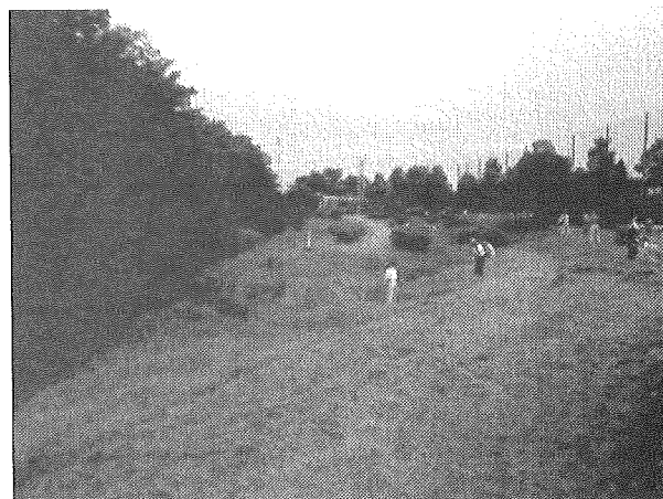
下流端から下流を臨む：除草中
