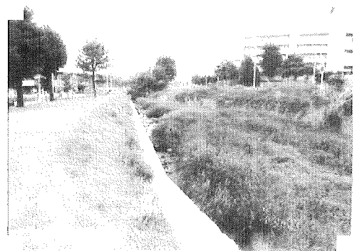
台風により堆積物で藤沢川中洲盛り上がる
