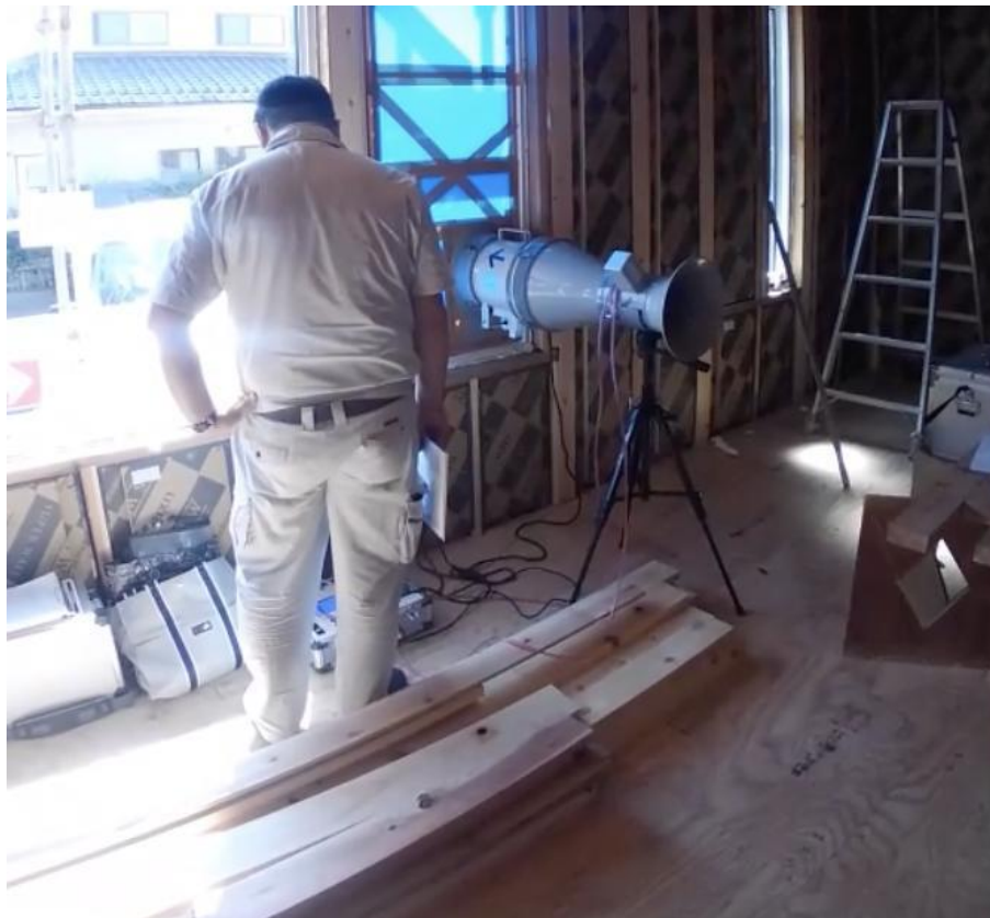
どのくらい建物に隙間がないかの確認
