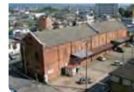
旧安田銀行担保倉庫
