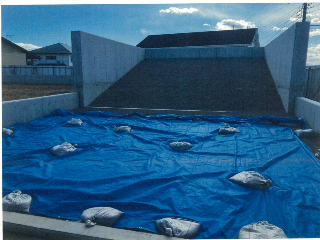
土砂災害訓練施設
