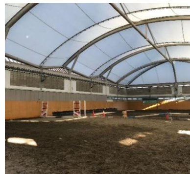
11-3 日本初の技術で作られた建造物
