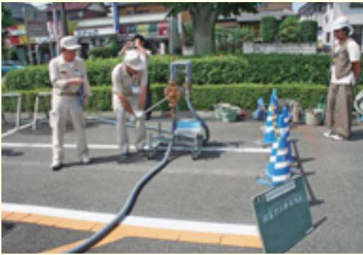
▲耐震性貯水槽の使用方法説明会 (7月15日、ひろせ老人福祉センターにて)
