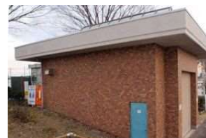
敷島汚水中継ポンプ場
