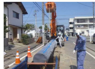
配水管の耐震化の様子
