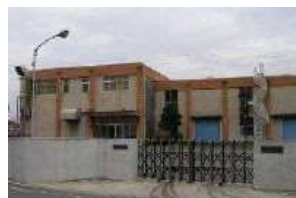
天川ポンプ場
