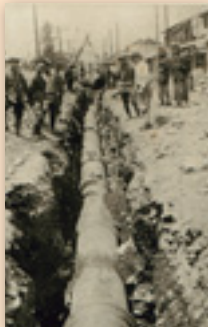
配水管布設工事
