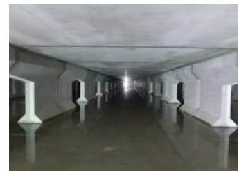
雨水対策:雨水調整池内部
