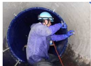
改築更新:管路内での作業(管更生)
