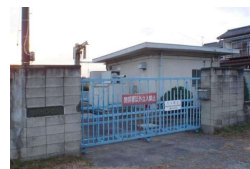
岩神ポンプ場
