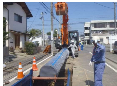
配水管の耐震化の様子
