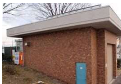
敷島汚水中継ポンプ場
