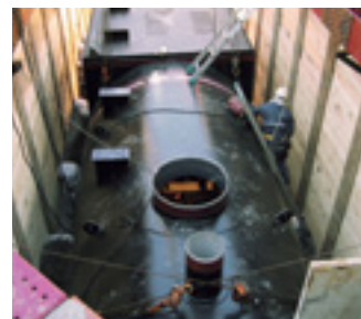
▲飲料水兼用耐震性貯水槽埋設工事の様子
