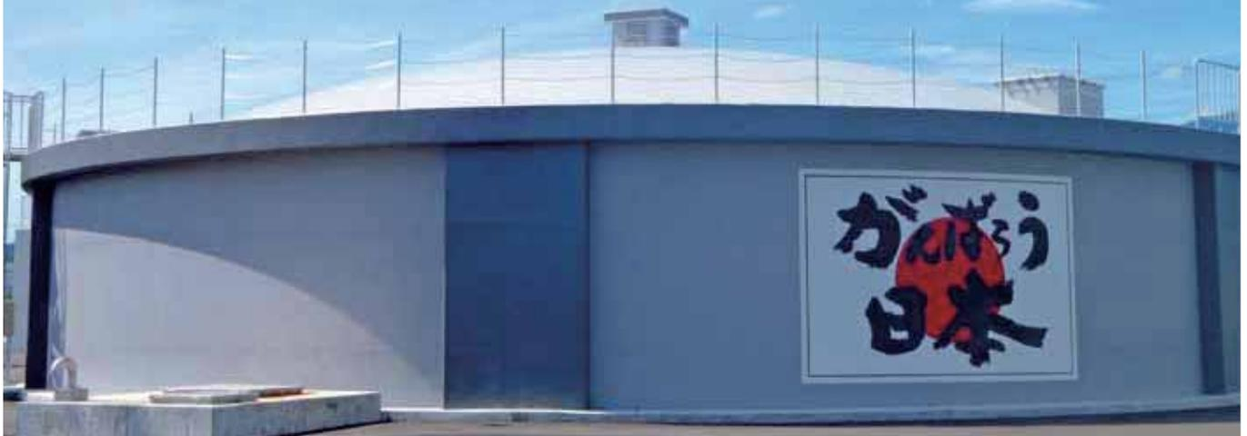
稲里浄水場は、粕川地区の西部に位置しています。配水区域を拡大するため既存配水池の容量900㎡を1,700㎡に増大するとともに、施設の老朽化を解消して耐震化を図るため、平成22から23年度の2か年事業で整備しました。
