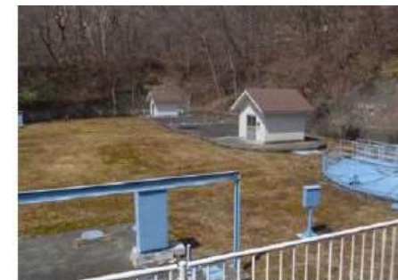
赤城山大洞処理場
