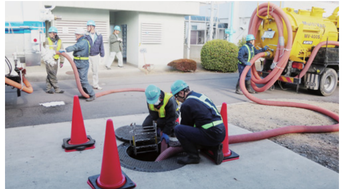
④汚泥の吸引運搬（吸引した汚泥を水質浄化センターへ運搬し、放流しています）
