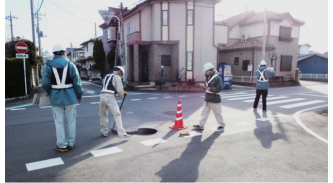
②管路調査（マンホールを開けて、中の状況を確認しています）
