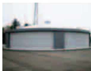
《H23 年度建設 稲里浄水場》
