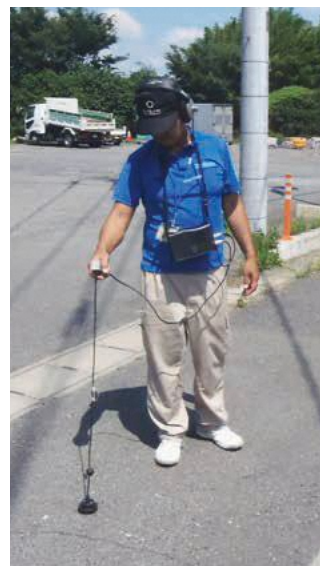
漏水調査中です
