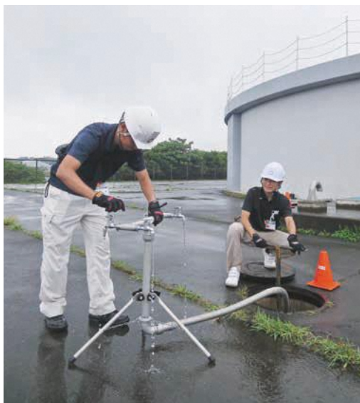
応急給水の作業中です
