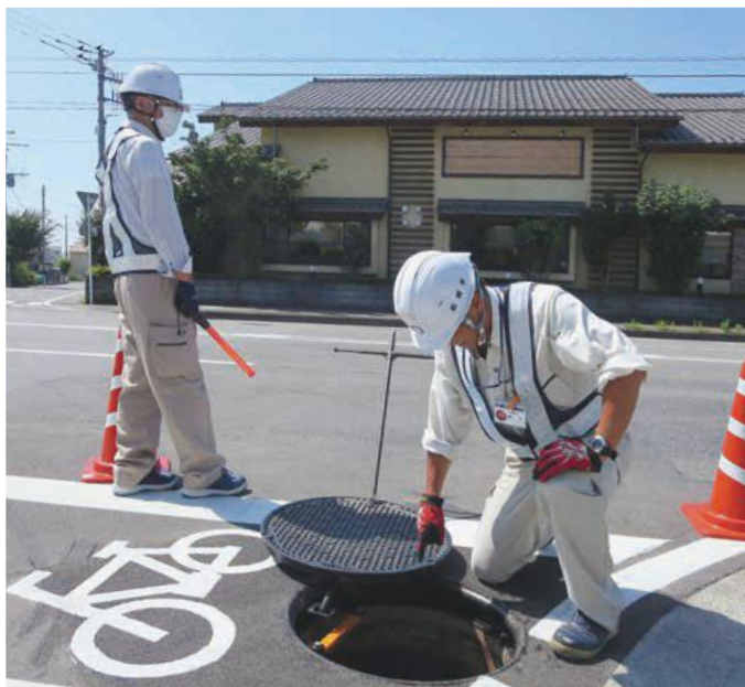
マンホール内部の確認中です
