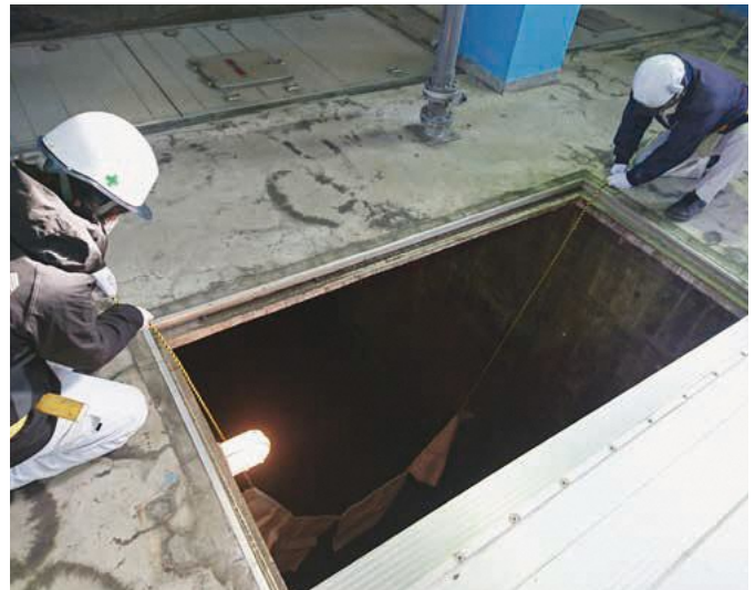
④水質事故訓練（オイルマット 注1 の設置） 注1 油を吸着するマット
