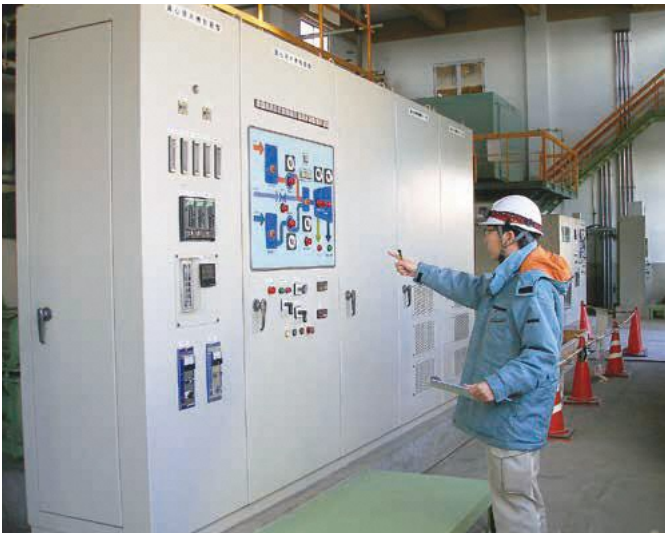
③重点施設緊急点検（機器類の確認）
