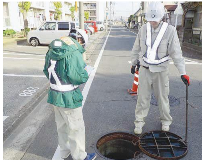
②管路調査（マンホール内の確認）
