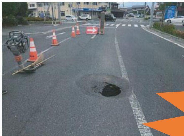
※ H30年度発生の直径約1mの道路陥没
