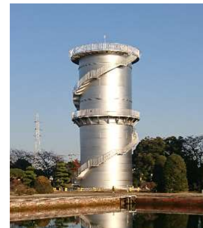
【更新した敷島浄水場の配水塔の写真】
