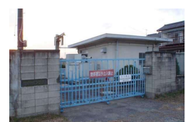
岩神ポンプ場
