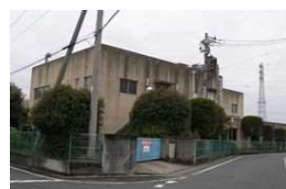
天川大島第一中継ポンプ場
