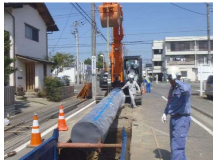
配水管の耐震化の様子
