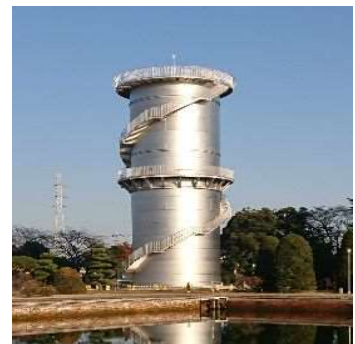
令和2年度完成の新配水塔
