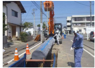
配水管の耐震化の様子
