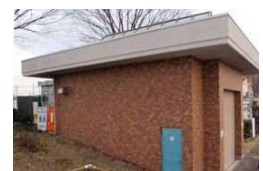
敷島汚水中継ポンプ場
