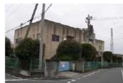
天川大島第一中継ポンプ場
