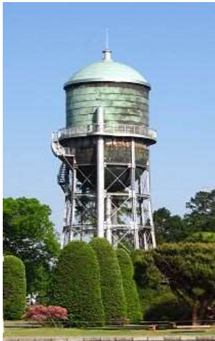
左) 昭和4年から稼働している水道タンク
