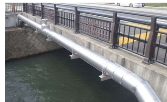
配水管 (水管橋)
