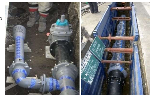
管路耐震化の様子
