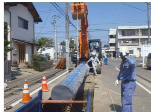
配水管の耐震化の様子
