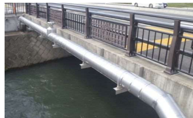
配水管（水管橋）
