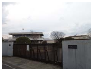
8 下細井浄水場
