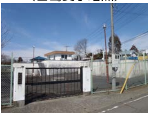
31 芦ヶ関浄水場
