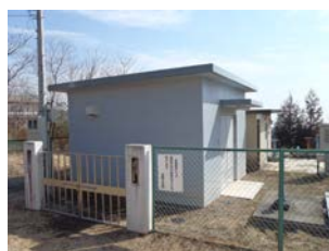
17 二本木浄水場
