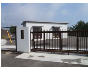
16 堀久保浄水場
