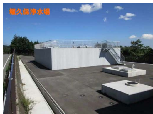
平成 25 年 2 月完成（緊急遮断弁設置）
