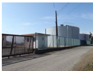
5 小坂子浄水場 (小坂子受水地点)
