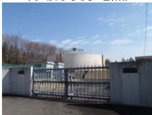
10 金丸第2浄水場
