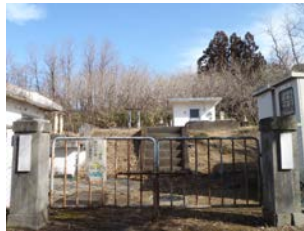
26 上西峰浄水場
