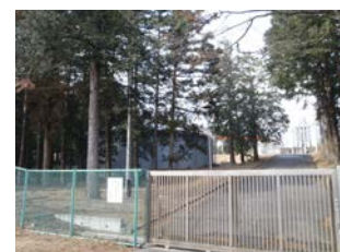
18 苗ヶ島浄水場
