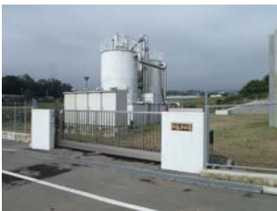
28 田島浄水場 (田島受水地点)
