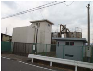
4 東片貝浄水場
