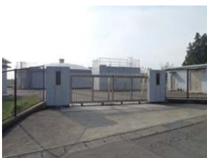
13 東金丸第2浄水場
