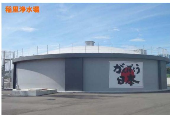
平成 24 年 2 月に完成（緊急遮断弁設置）
