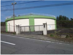
22 室沢浄水場 (室沢受水地点)
