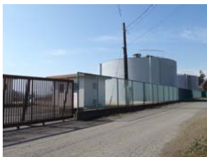
7 小坂子浄水場 (小坂子受水地点)
