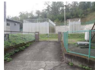
12 東金丸第1浄水場
