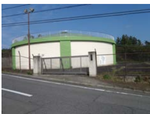
10 室沢浄水場 (室沢受水地点)
