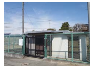
9 金丸第1浄水場
