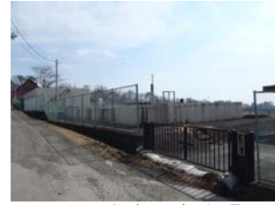
21 中之沢浄水場
