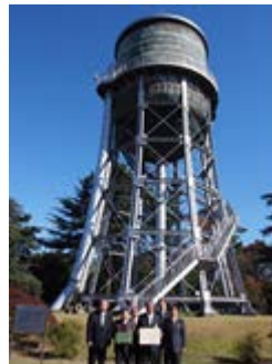
■敷島浄水場■ 敷島浄水場配水塔が土木学会 選奨土木遺産に選出されました。
