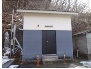
20 湯之沢浄水場
