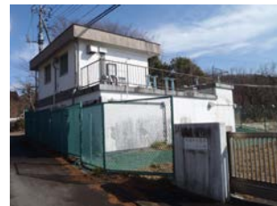
30 竜ノ口浄水場
