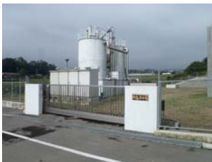
28 田島浄水場 (田島受水地点)
