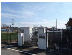
34 大松山浄水場
