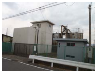
4 東片貝浄水場
