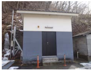
20 湯之沢浄水場
