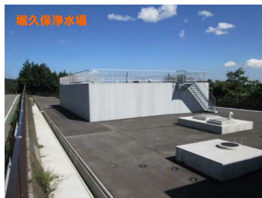
【堀久保浄水場（宮城地区）】
