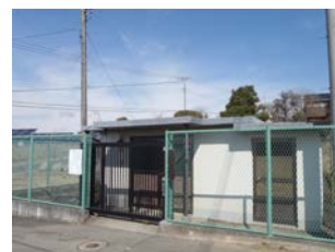
9 金丸第1浄水場
