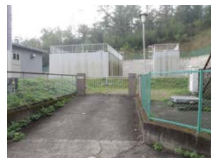
12 東金丸第1浄水場
