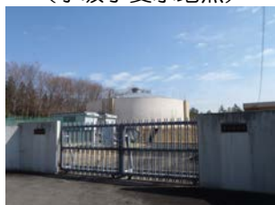
10 金丸第2浄水場
