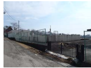
21 中之沢浄水場
