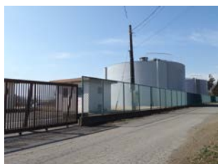
7 小坂子浄水場 (小坂子受水地点)
