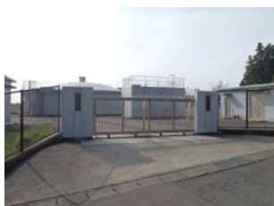
13 東金丸第2浄水場
