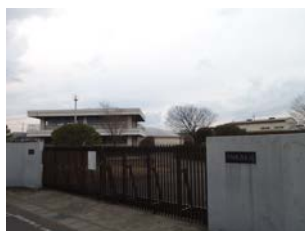
8 下細井浄水場
