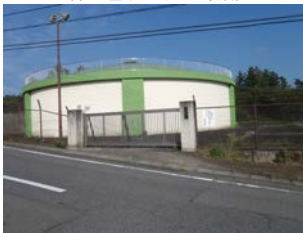
22 室沢浄水場 (室沢受水地点)
