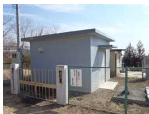
17 二本木浄水場
