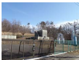
35 西大河原浄水場
