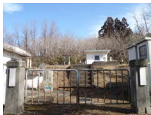
26 上西峰浄水場
