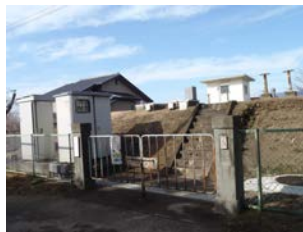
29 小原目浄水場
