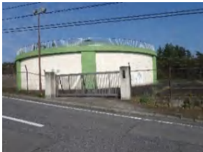
10 室沢浄水場 (室沢受水地点)
