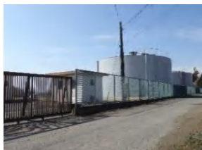
7 小坂子浄水場 (小坂子受水地点)
