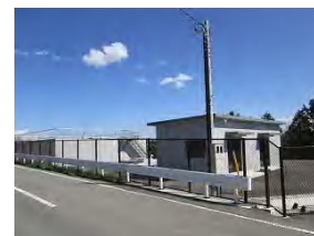
15 堀久保浄水場
