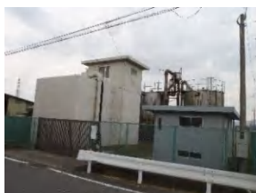
4 東片貝浄水場
