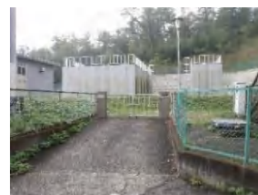
12 東金丸第1浄水場
