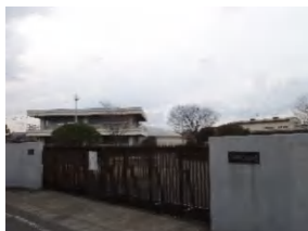
8 下細井浄水場
