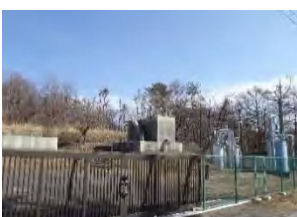
32 西大河原浄水場
