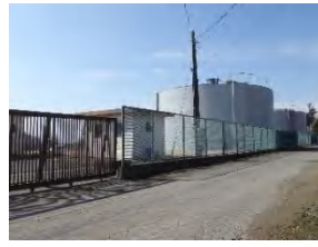
5 小坂子浄水場 (小坂子受水地点)
