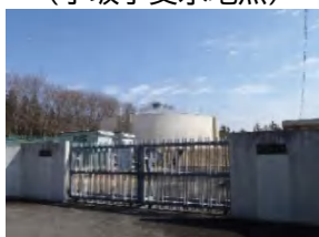
10 金丸第2浄水場
