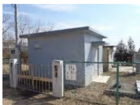
16 二本木浄水場
