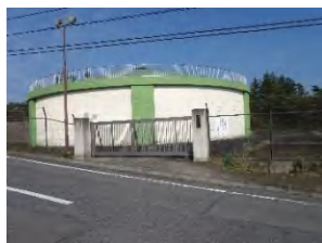
20 室沢浄水場 (室沢受水地点)
