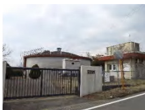
17 柏倉浄水場 (柏倉受水地点)
