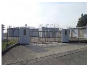
13 東金丸第2浄水場
