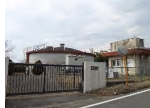
9 柏倉浄水場 (柏倉受水地点)
