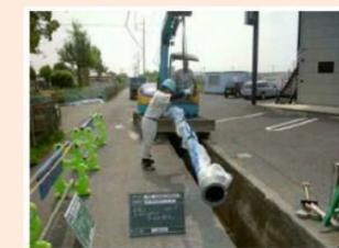
写真:耐震管の布設工事
