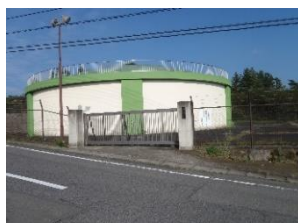
20 室沢浄水場 (室沢受水地点)
