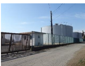
5 小坂子浄水場 (小坂子受水地点)
