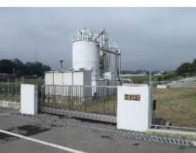
11 田島浄水場 (田島受水地点)
