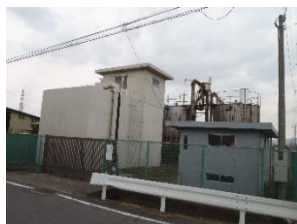
4 東片貝浄水場
