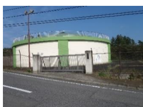
10 室沢浄水場 (室沢受水地点)
