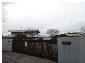
8 下細井浄水場
