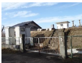
27 小原目浄水場
