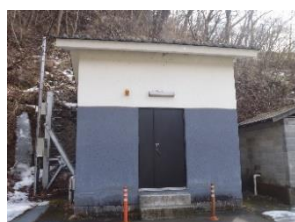
18 湯之沢浄水場
