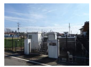
32 大松山浄水場
