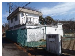
28 竜ノ口浄水場
