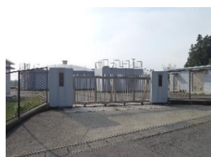
13 東金丸第2浄水場
