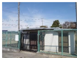
9 金丸第1浄水場
