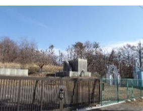
33 西大河原浄水場
