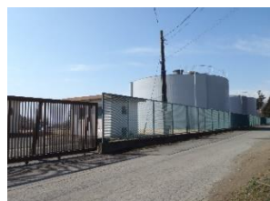
7 小坂子浄水場 (小坂子受水地点)
