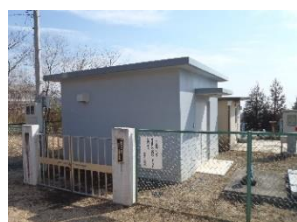
16 二本木浄水場
