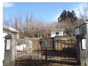
24 上西峰浄水場
