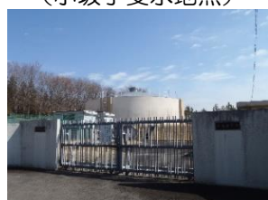
10 金丸第2浄水場
