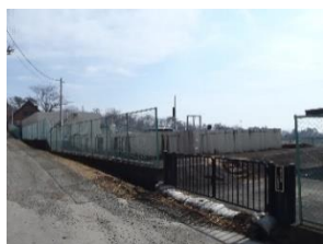
19 中之沢浄水場
