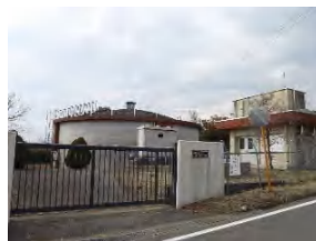
17 柏倉浄水場 (柏倉受水地点)
