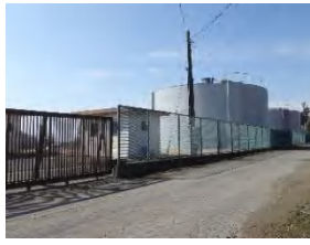
5 小坂子浄水場 (小坂子受水地点)
