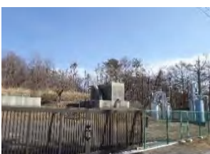
32 西大河原浄水場
