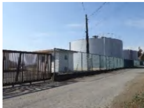
7 小坂子浄水場 (小坂子受水地点)
