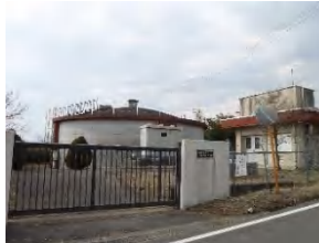
9 柏倉浄水場 (柏倉受水地点)
