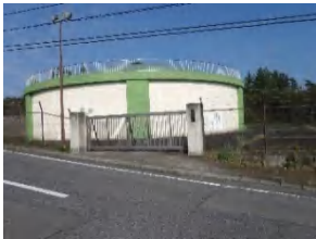
10 室沢浄水場 (室沢受水地点)
