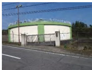
20 室沢浄水場 (室沢受水地点)
