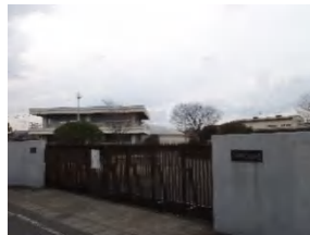
8 下細井浄水場
