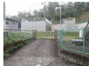
12 東金丸第1浄水場
