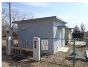
16 二本木浄水場
