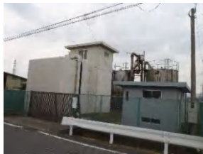
4 東片貝浄水場
