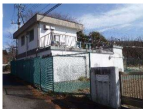
27 竜ノ口浄水場
