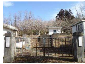
24 上西峰浄水場
