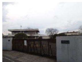
8 下細井浄水場
