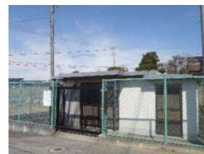
9 金丸第1浄水場
