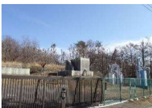
32 西大河原浄水場
