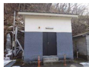
18 湯之沢浄水場
