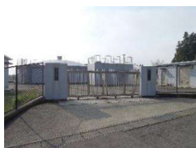
13 東金丸第2浄水場
