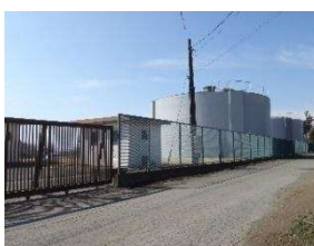
5 小坂子浄水場 (小坂子受水地点)
