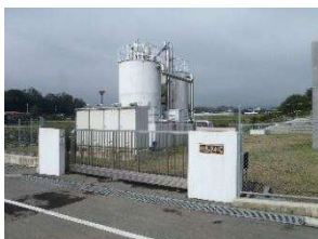
11 田島浄水場 (田島受水地点)
