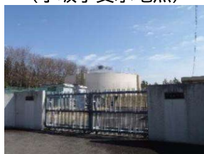
10 金丸第2浄水場
