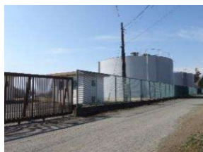
7 小坂子浄水場 (小坂子受水地点)
