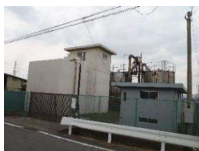
4 東片貝浄水場
