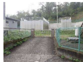
12 東金丸第1浄水場
