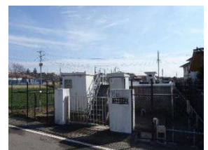
31 大松山浄水場
