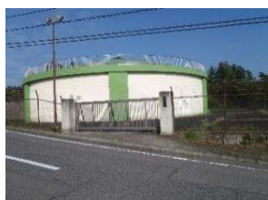
10 室沢浄水場 (室沢受水地点)
