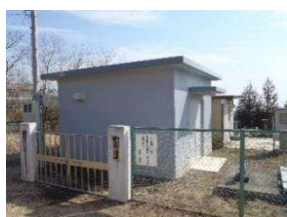
16 二本木浄水場
