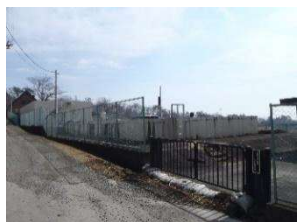
19 中之沢浄水場
