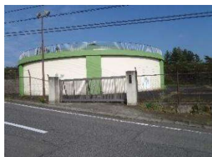
20 室沢浄水場 (室沢受水地点)
